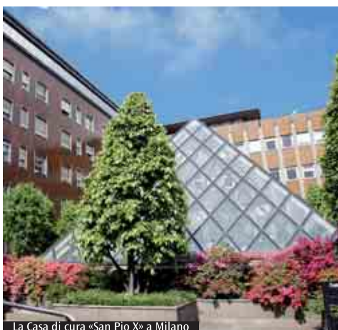
La Casa di cura «San Pio X» a Milano
